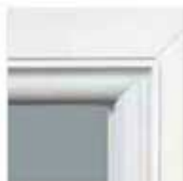
Pose en rénovation
